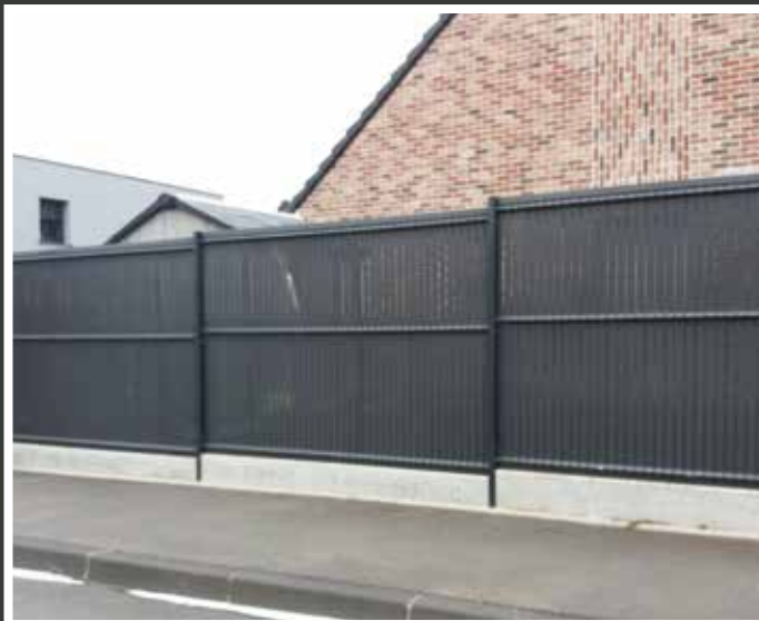
Pose à décrochement régulier
