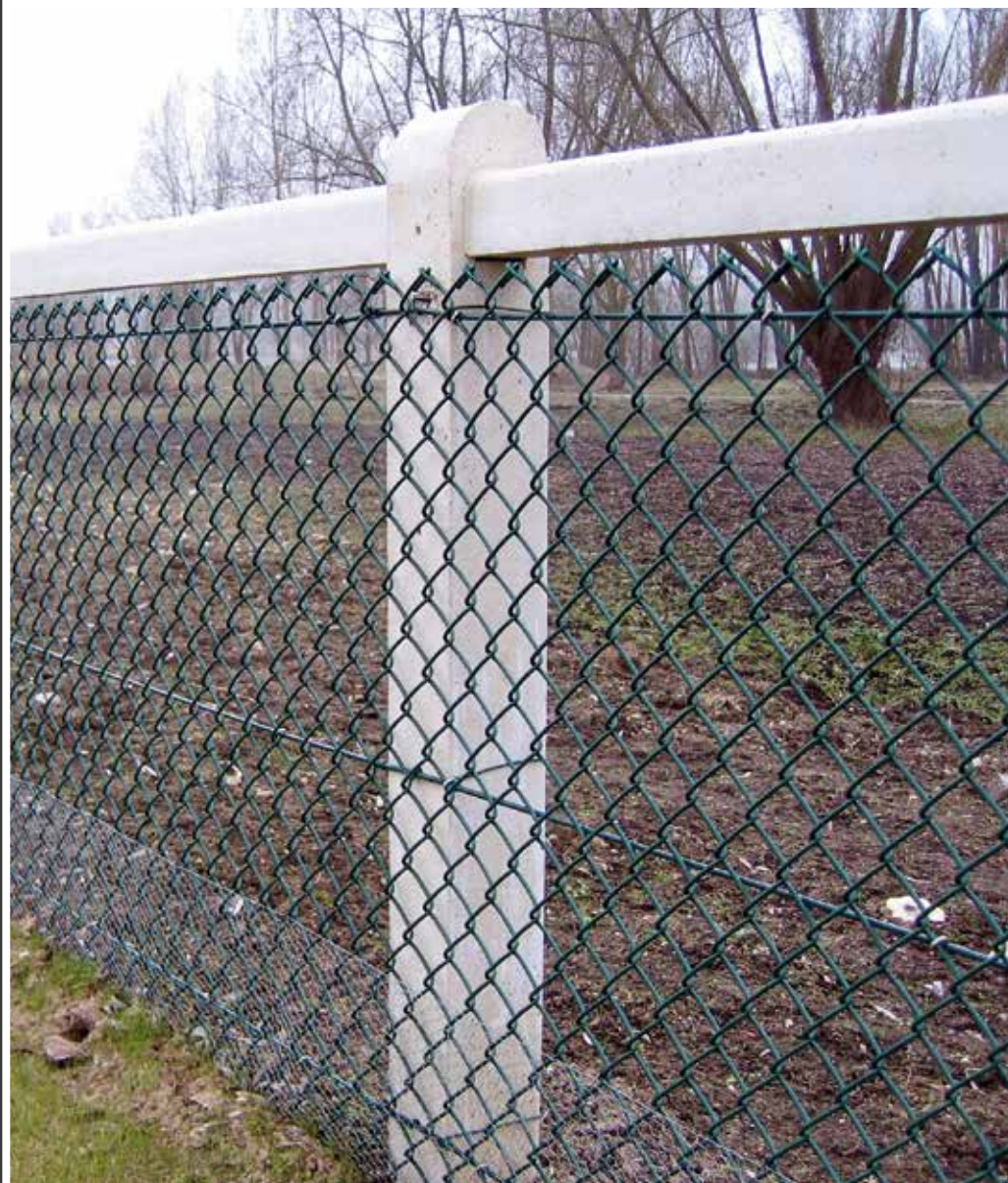
Grillage simple torsion sur poteaux béton avec lisses
