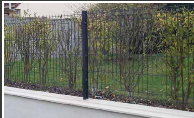
Pose sur muret avec percement par carottage à eau
